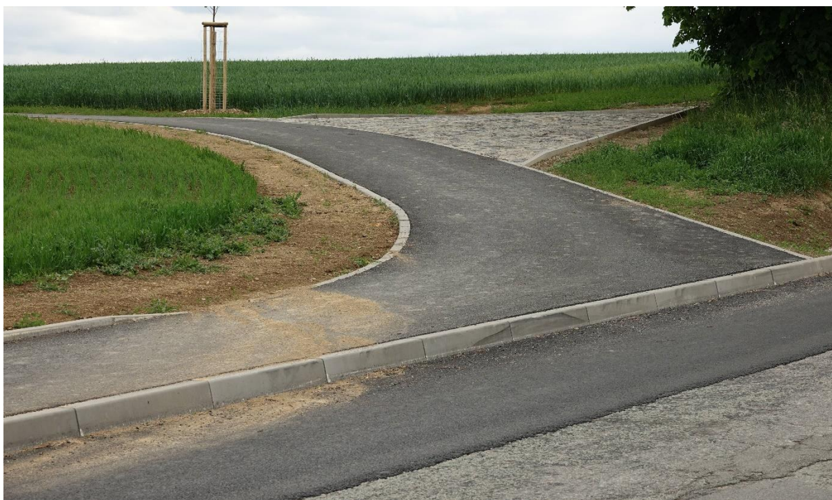
Obrázek 2: Napojení cyklostezky s přítokem vody do vozovky
